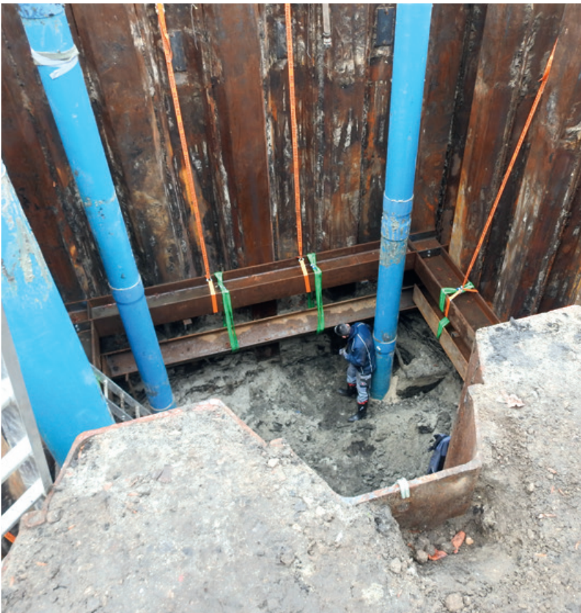
Abb. 7 – Trockene Baugrube 1 und Vakuumbrunnen
