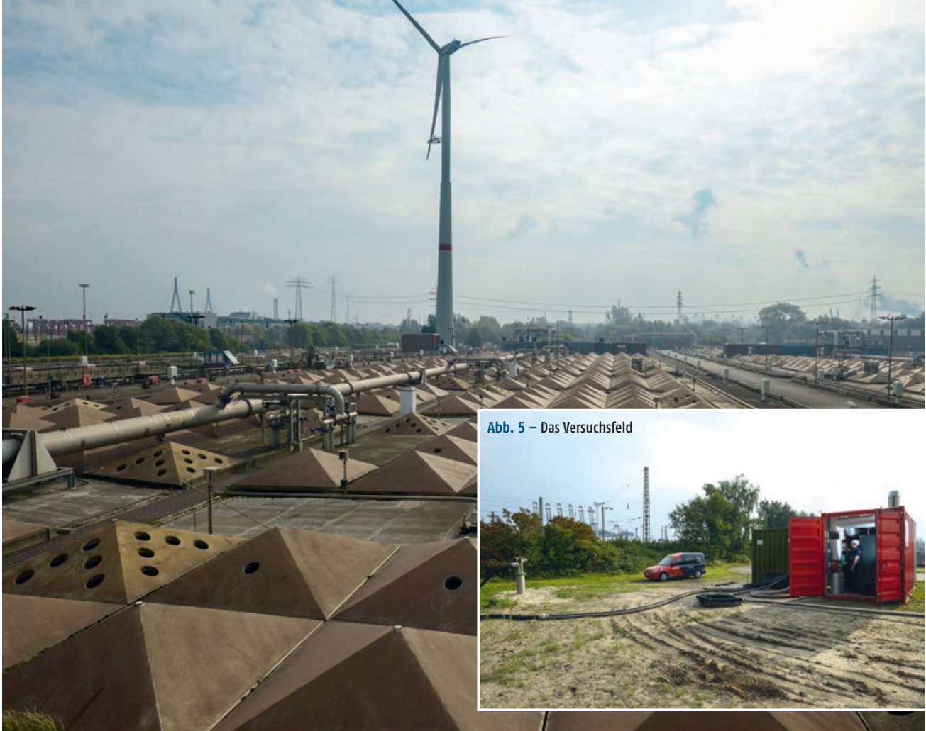
Abb. 4 – Klärwerk im Hamburger Hafen
