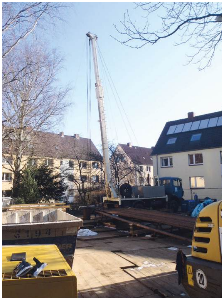
Abb. 3: Brunnenbaustelle innerhalb der Wohnbebauung in Hamburg-Harburg
